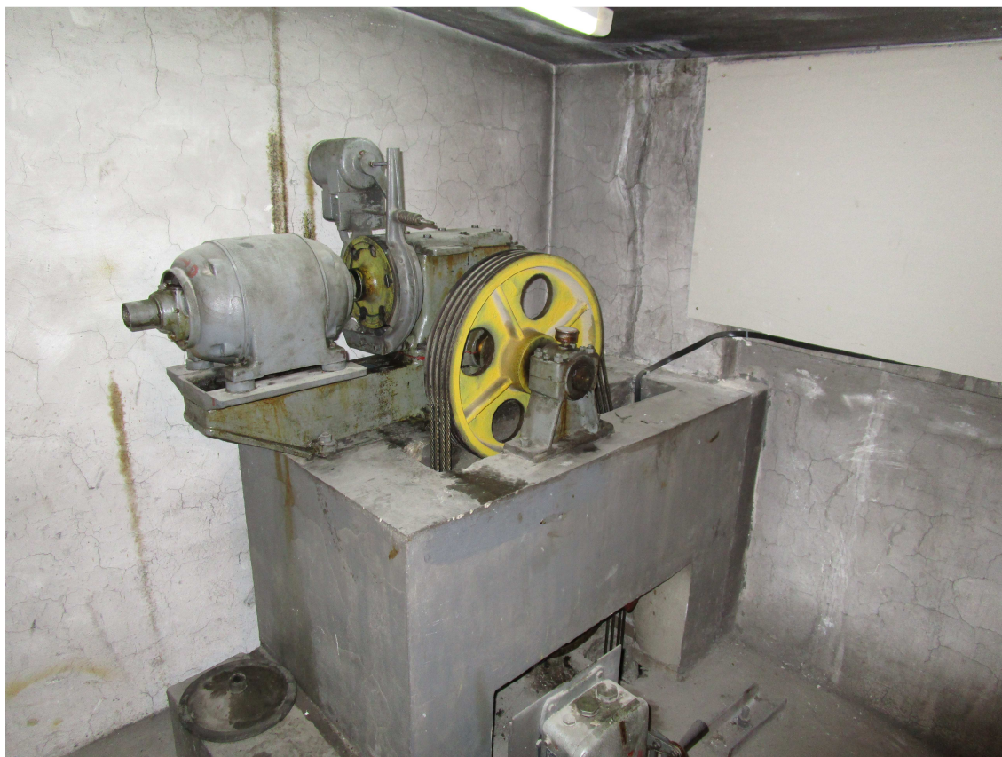
Obr č.1. Strojovna výtahu v 6.NP
